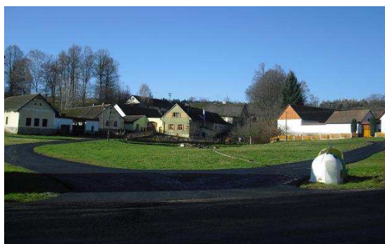
opravená návěs v Předbořicích
